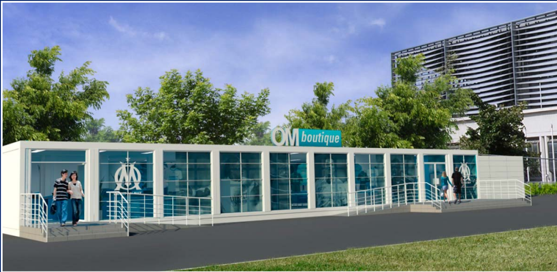
Signalétique, vitres teintées, espace intérieur maximisé, bardage acier blanc...
